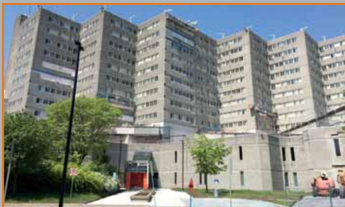
Réfection de l'enveloppe du bâtiment, Garnison Saint-Jean, 2017
